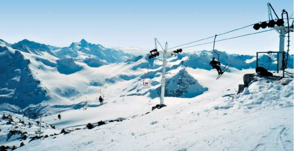
Рис. 79. Канатная дорога на горнолыжной базе в Приэльбрусье
