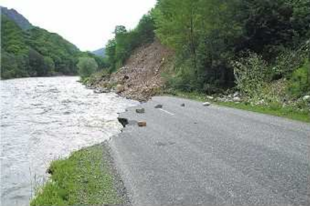
Рис. 68. Разрушенные в результате ливневых дождей мост и дорога в Ставропольском крае
