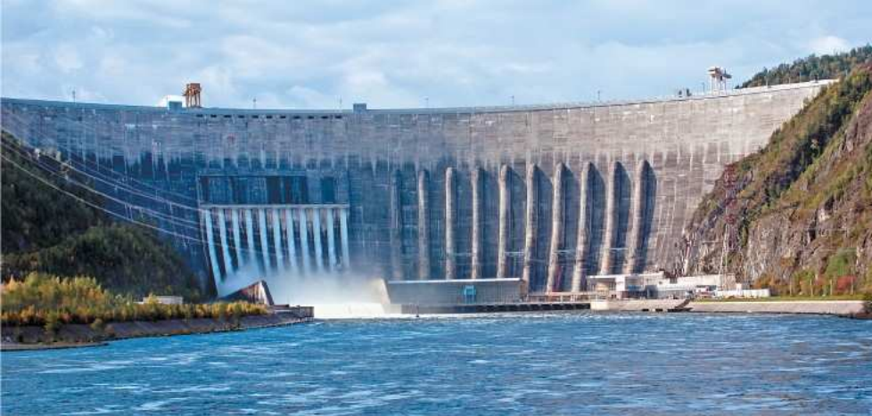
Рис. 8. Плотина Саяно-Шушенской ГЭС
