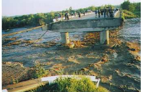
Рис. 68. Разрушенные в результате ливневых дождей мост и дорога в Ставропольском крае
